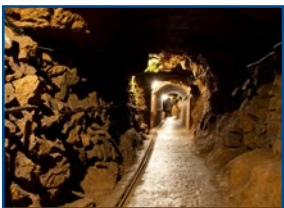
巷道中集水坑排水
